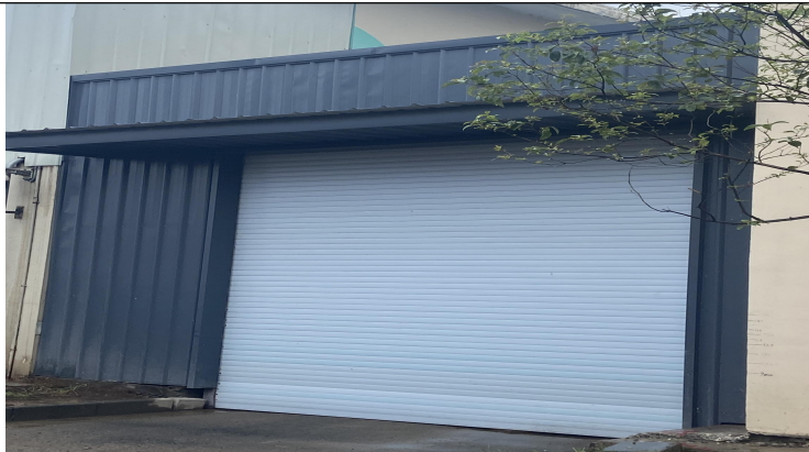
一般固废暂存场所
