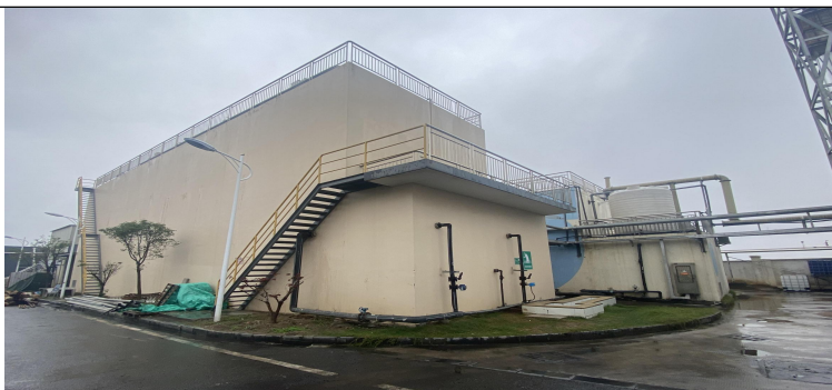
200t/d 污水处理站
