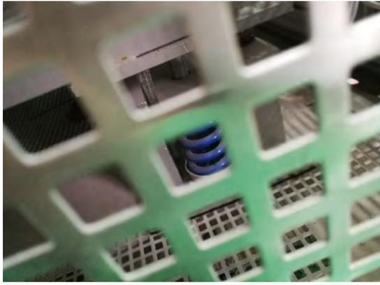
变压器弹簧减震器
