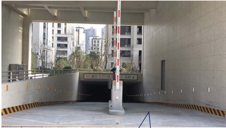
地下车库出入口减振带
